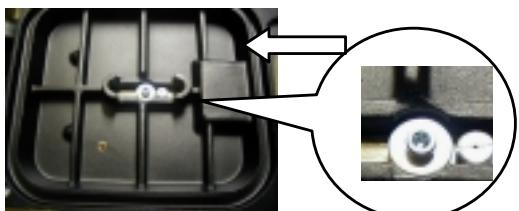
Spænd vakuumhåndtaget fast med en spændeskive og unbracoskruer M8x30 og montér fodforseglingen i revnen.
